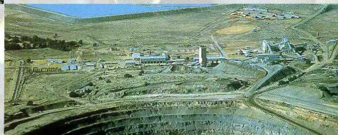
Die Finch Mine in Süd-Afrika ist eine primäre Diamantlagerstätte, wo der Schlot aus Kimberlit direkt im Tagbau abgebaut wird. (Bild: De Beers)
